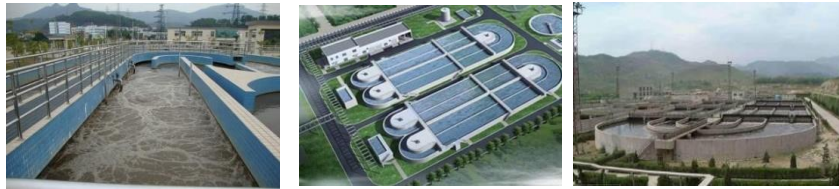
图 4-6-8 国内氧化沟处理工艺运行实例
